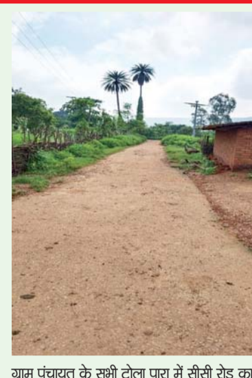
ग्राम पंचायत के सभी टोला पारा में सीसी रोड का बेहतर निर्माण कराया गया है। बारिश के दिनों में कीचड़ से तलपथ होकर घर पहुंचने की समस्या से ग्रामीणों को निजात मिल गई है।
