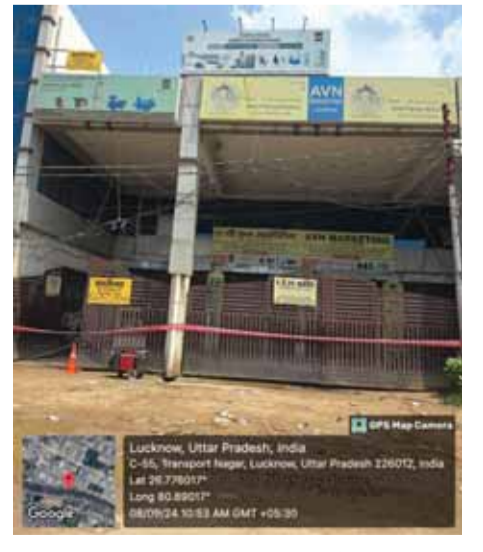
थाना सरोजनी नगर पुलिस ने मुकदमा दर्ज कर मामले की जांच में जुट गई है। ट्रांसपोर्ट नगर चौकी इंचार्ज के अनुसार सी.54 नियर पीतान्बर डायनोस्टिक सेंटर ट्रांसपोर्ट नगर कानपुर रोड लखनऊ स्थित एक व्यावसायिक बिल्डिंग अचानक गिर गई।
