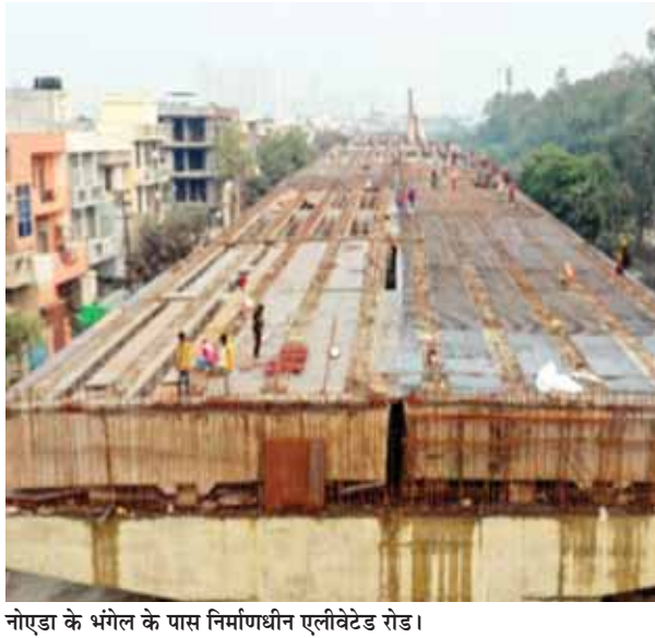
नोएडा के भंगेल के पास निर्माणाधीन एलिवेटेड रोड।
